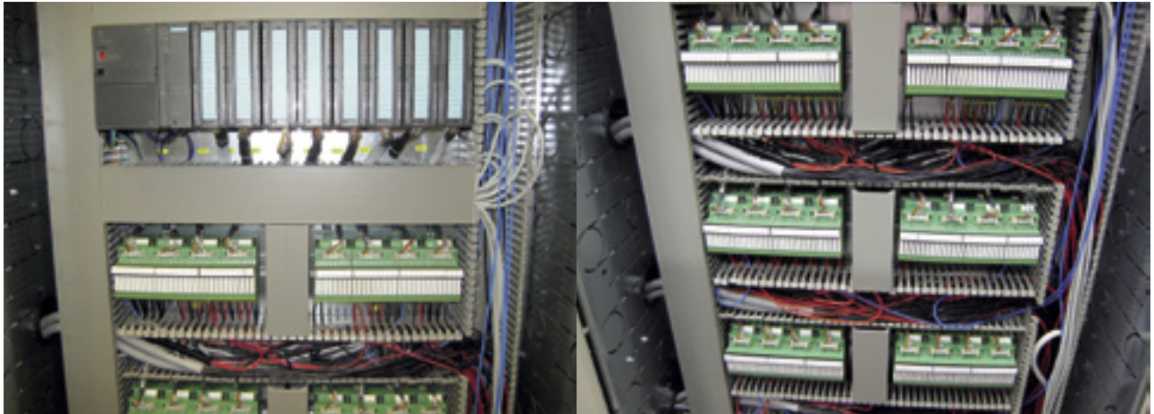
Logiikat on kytketty VARIOFACE-järjestelmäkaapeloinnin avulla.
